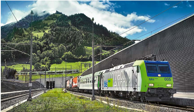
Le portail nord du tunnel de base du Lötschberg.
